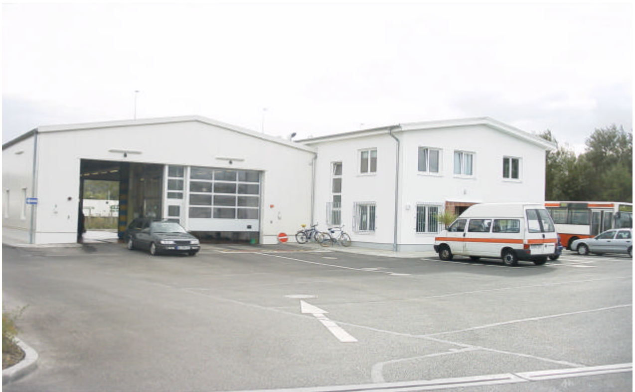
Wartungshalle mit Verwaltungstrakt
